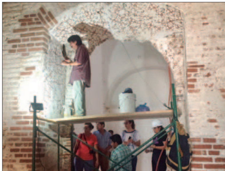
▲ En la fotografía, proceso de restauración del convento de Santo Domingo de Guzmán, 2019. Foto María del Carmen Castillo
